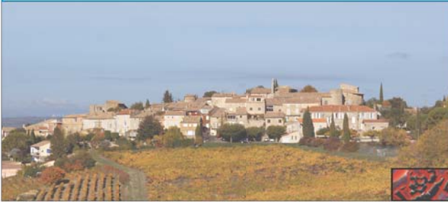
Le vieux village : le projet préserve cet ensemble bâti à forte valeur patrimoniale et les grands cônes de vues qui permettent de l'admirer.
