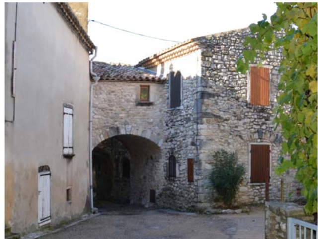
Traboule et vieilles pierres dans le village. Leurs anfractuosités et trous constituent des gîtes potentiels pour certaines espèces de chauves-souris.
