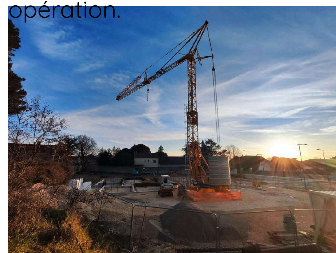
Le début des travaux
