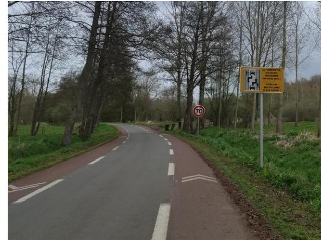
**Voie où les véhicules motorisés circulent sur une voie centrale et les cyclistes sur la partie revêtue de l'accotement appelée rive.**
